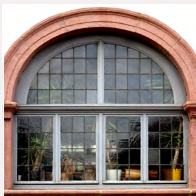
Rundbogenfenster, Bleiverglasung
