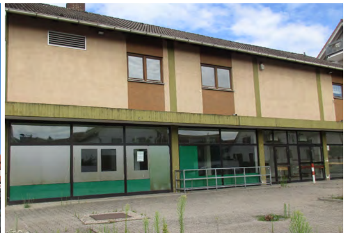
Negativ ortsbildprägendes Gebäude
