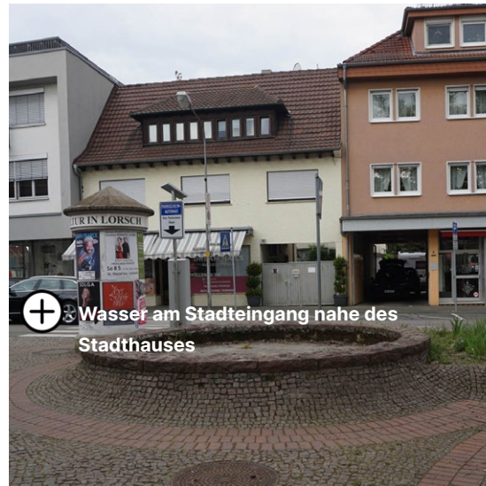
Abb. 71: Brunnen Kaiser-Wilhelm Platz defekt
