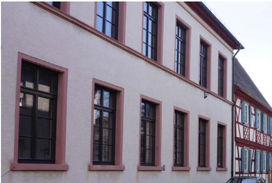
Abb. 36: Fassadenmaterial: Putz und Buntsandstein, Hintergrund Sichtfachwerk
