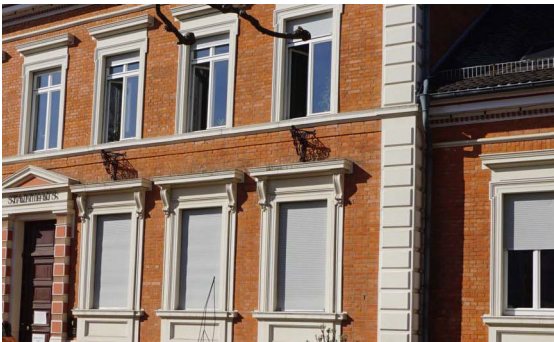
Abb. 37: Ziegelmauerwerk am Stadthaus
