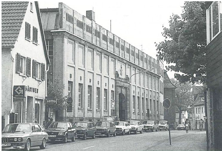
Abb. 25: Zigarrenfabrik Carstanjen in der Römerstraße, Abriss 1984
